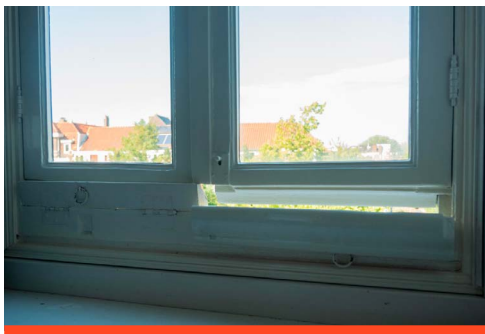
▲ Zolder Rijnsburgerweg 46 Leiden, 1893. Rechts is de onderdorpel naar binnen/beneden geklapt voor ventilatie
