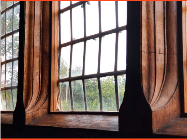
▲ Woonhuis, Marelaan 1 Oegstgeest, 1939. boven voordeur onder detail woonkamerramen. Het betreft bouwmaterialen afkomstig uit originele Hollandse Renaissance-bouwwerken
